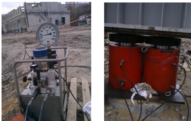
Рис. 1 – Установка для испытания свай
