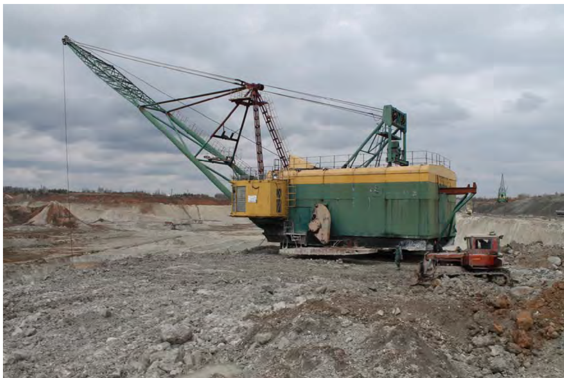
Рисунок 1 - Одноковшовый экскаватор на карьере по добыче мергеля (ОАО «Белорусский цементный завод, г. Костюковичи)
