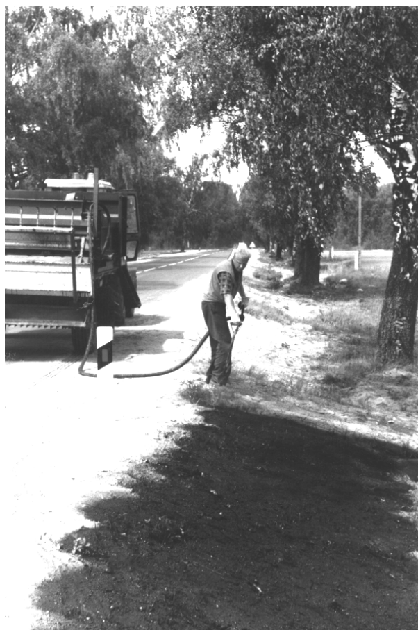
Рис. 5.15. Укрепление откоса насыпи путем засева трав с последующим нанесением противозерозионного слоя
