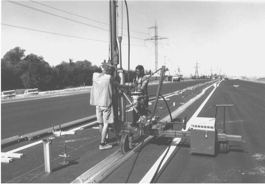
Рис. 7.7. Погружение стоек барьерного дорожного ограждения в грунт земляного полотна
