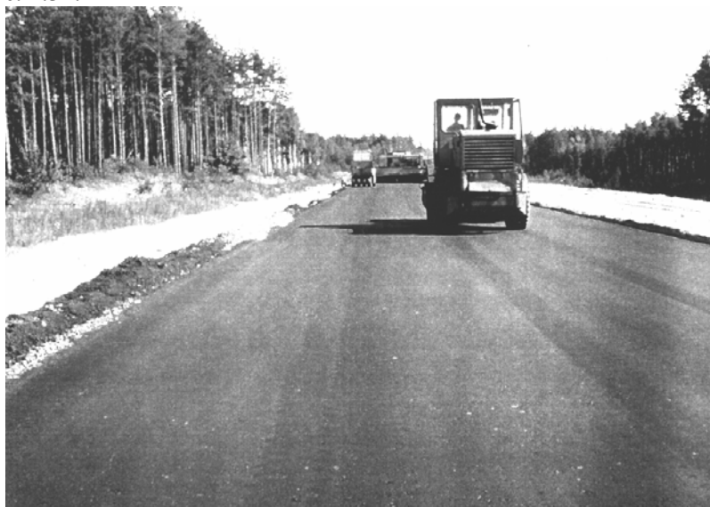
Рис. 2.34. Рисайклинг-асфальт, готовое покрытие
