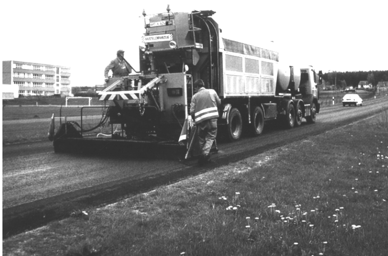
Рис. 2.19. Поверхностная обработка асфальтобетонного покрытия: а – автогудронатором «Дорвектор»; б – машиной WEIX 624
