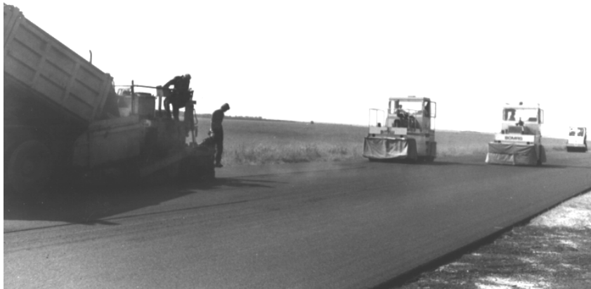
Рис. 3.19. Укладка и уплотнение асфальтобетонной смеси
