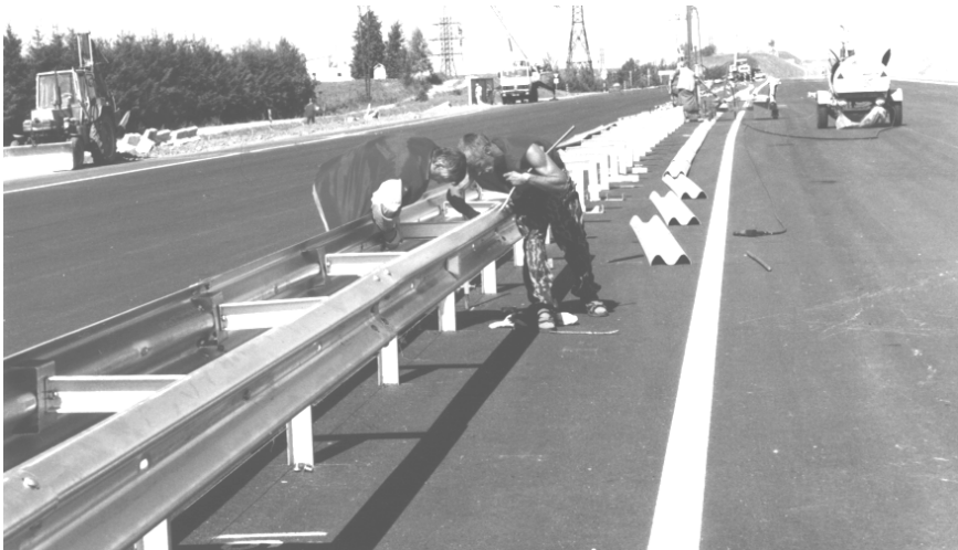
Рис. 7.8. Монтаж профильного бруса барьерного дорожного ограждения (на разделительной полосе МКАД)
