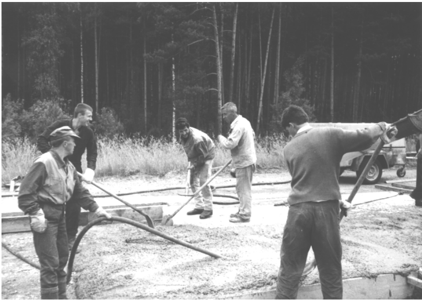
Рис. 3.16. Полная переделка плит (заполнение цементобетоном)
