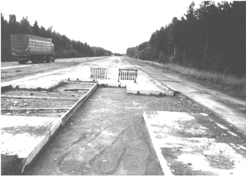
Рис. 3.14. Полная переделка плит (выборка на всю глубину)
