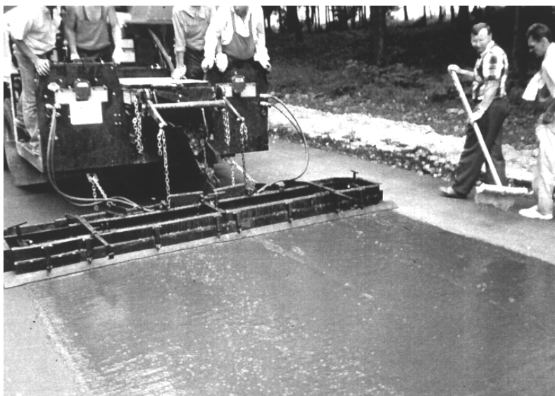
Рис. 2.23. Применение технологии «Сларри Сил» при ремонте асфальтобетонного покрытия: а – ликвидация колеи в полосе наката; б – устройство защитного слоя
