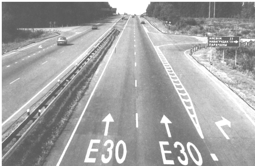
Рис.1.1. Общий вид автомобильной дороги М1/Е30
