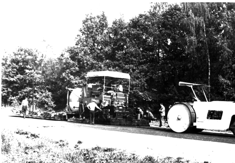
Рис. 2.33. Работы по выполнению ремиксинга (а); ремиксинг дорожного покрытия с помощью машины Vogele и дорожного катка (б)
