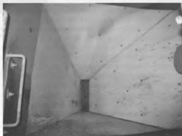
Рисунок 5 — Футеровочные плиты рудоспусков из СВМПЭ-композиатов
