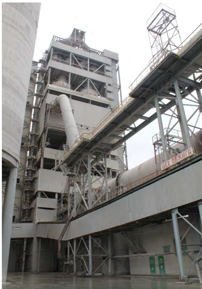
Рисунок 4 - Цех обжига цементного клинкера
