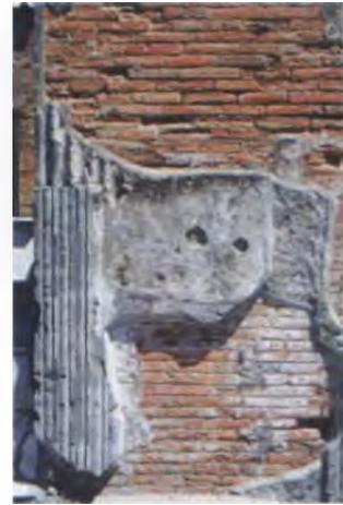
Рис. 4. Фрагмент стены древнеримского дома в Помпеях с остатками оштукатуривания
