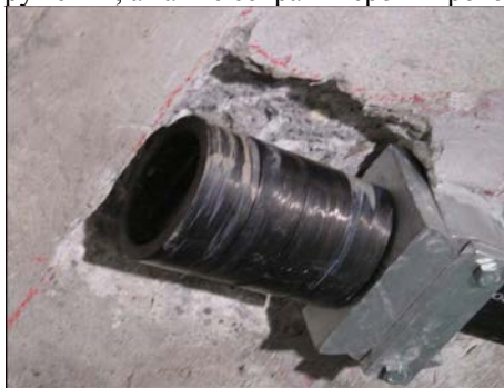
Рисунок 1. Анкеровка углеродной ленты
