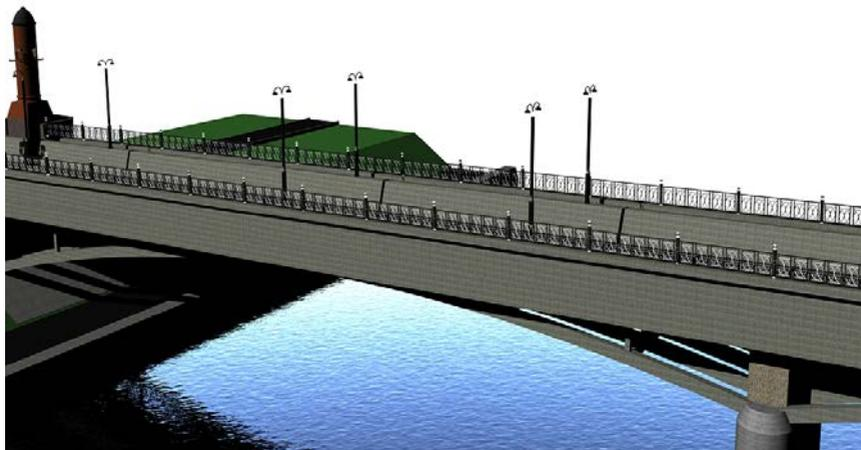
На мосту предусмотрена проезжая часть на 4 полосы движения и 2 тротуара по бокам от проезжей части. Высота над водой в около 11 метров.
