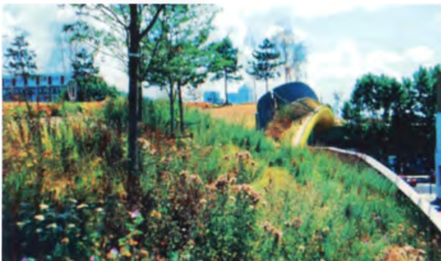
Рис. 15. Пересечение линейного парка Майл-Энд с автомагистралью выполнено в разных уровнях и имеет земляное покрытие с посадками деревьев и кустарников, благодаря чему сохраняется пространственная целостность парка. Лондон, Великобритания
