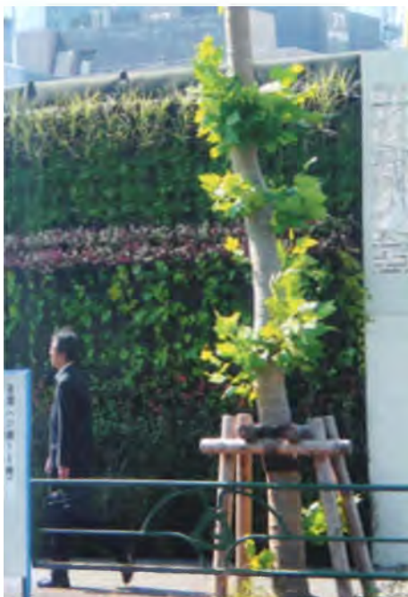
Рис. 17. «Живое» ограждение строительной площадки. Токио, Япония
