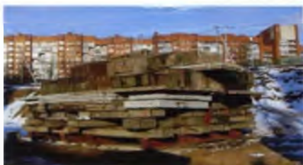
Рис. 2. Платформа для испытания свай с грузами из бетонных плит и блоков
