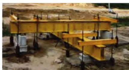
Рис. 3. Балочный стенд для испытания свай при вдавливании до 5000 кН
