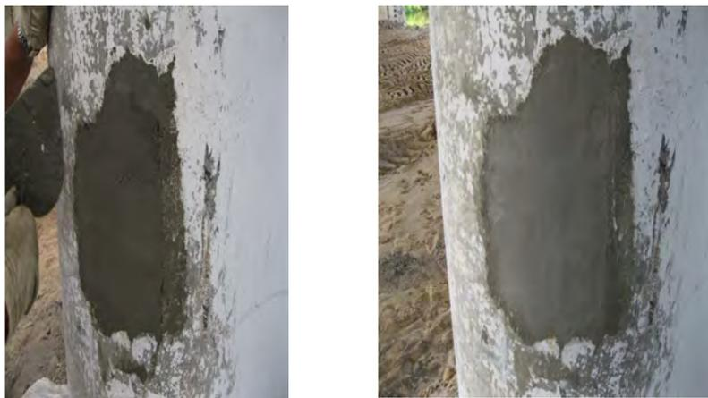
Рис. 2. Восстановление защитного слоя промежуточной опоры
