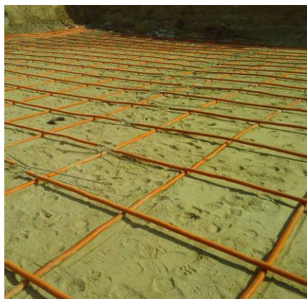
Рис. 3 – Горизонтальное армирование грунтовой подушки
