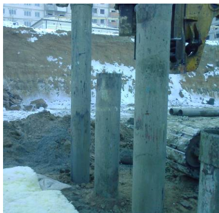
Рис. 2 – Устройство вертикальных армирующих элементов
