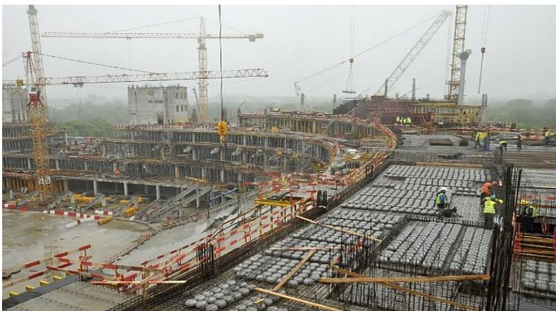
Рис.2. Строительство спортивного комплекса с использованием вкладышей
