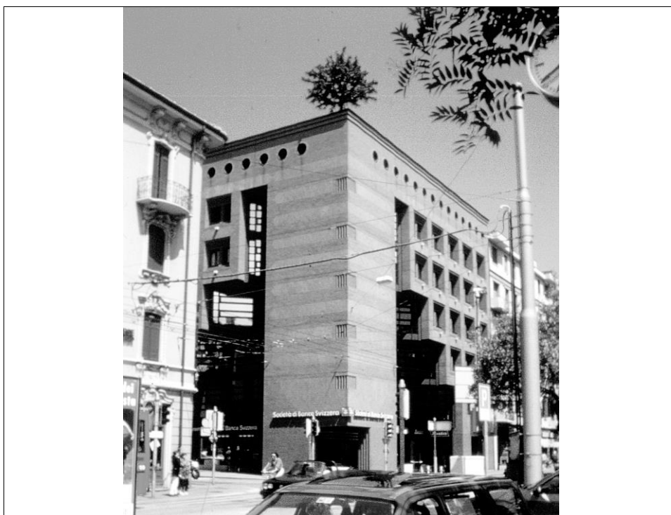
Рис. 5.23. Здание банка с одиноким деревом на крыше как символ экологического мышления (архит. М. Ботта), г. Лугано, Швейцария
