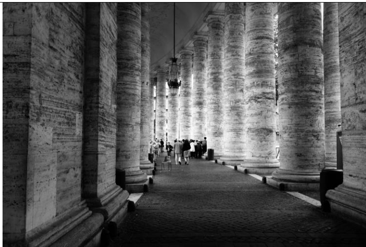
Рис. 5.33. Тектоника (художественное выражение работы строительных конструкций) колоннады, окружающая площадь перед собором св. Петра, выполненная в монументальном дорическом ордере (архит. Л. Бернини), Рим, Ватикан
