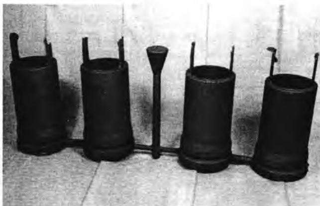
Рис. 14.4. Блок отливок гильз
