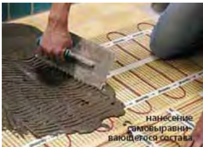
Рис. 19.10. Устройство стяжки под полы
