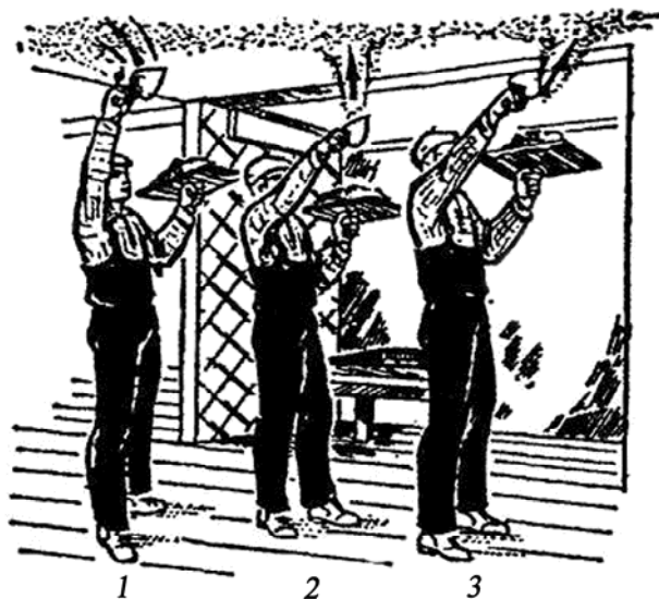
Рис. 16.5. Нанесение раствора на потолок 1 – через голову; 2 – над собой; 3 – от себя
