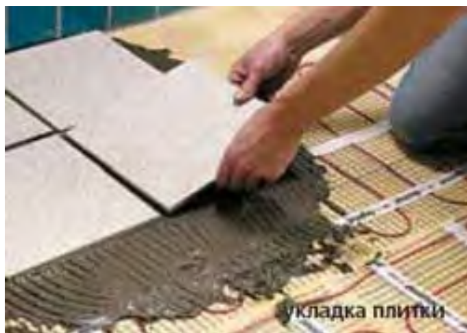
Рис. 19.11. Укладка пола из плитки
