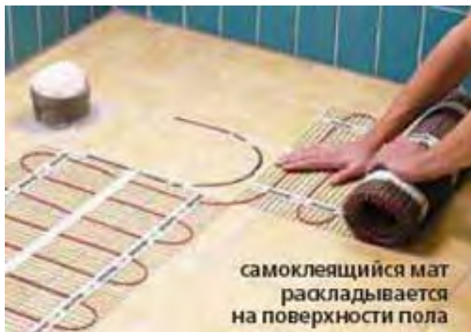
Рис. 19.9. Укладка электрических нагревательных матов
