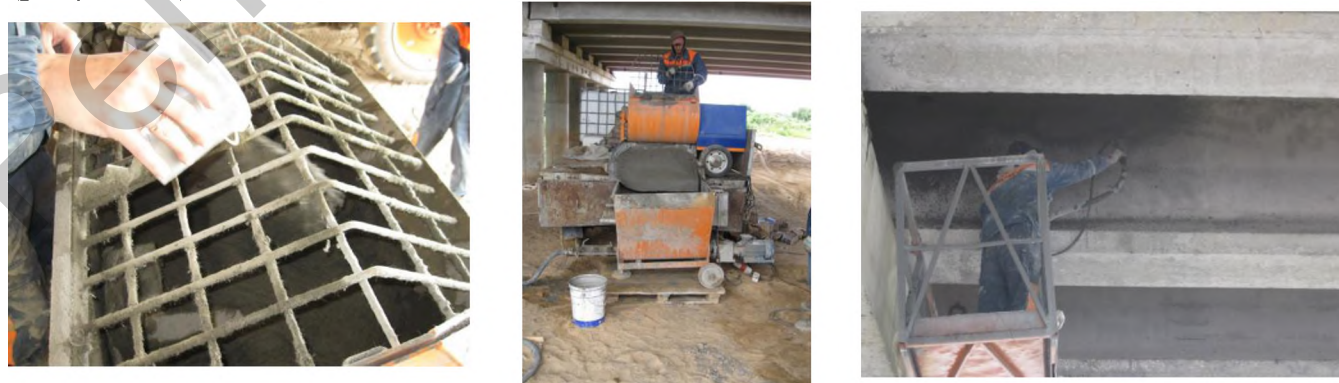
Рисунок 7. – Приготовление и нанесение торкрет-бетонного слоя
