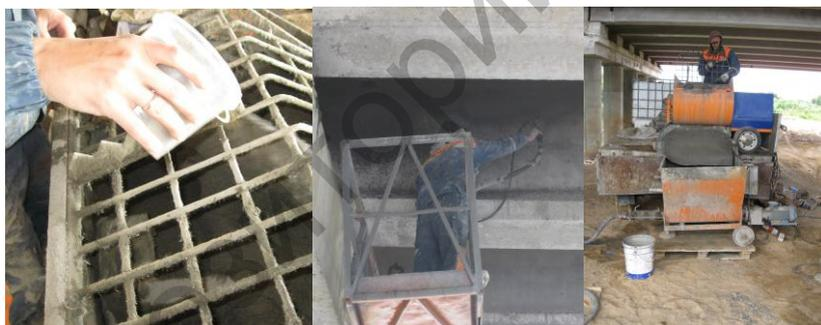
*а* – введение добавки      *б* – нанесение ремонтного бетона      *в* – установка для приготовления смеси
