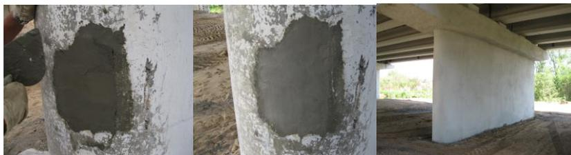
*а* – свежеложенный защитный слой      *б* – защитный слой через 90 суток      *в* – защитный слой через 14 и 27 месяцев
