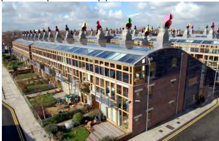
Рис.1 – Общий вид энергоэффективного здания
