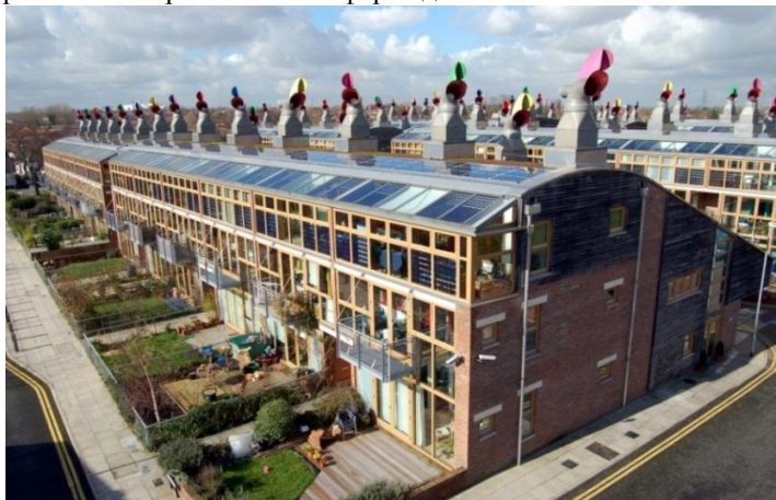
Рис.1 – Общий вид энергоэффективного здания
