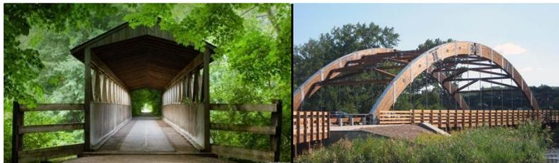
Кроме этого, обращается внимание на то, что, несущие конструкции деревянных мостов должны быть открытыми, хорошо проветриваемыми, доступными для осмотра. Мероприятия по повышению долговечности
