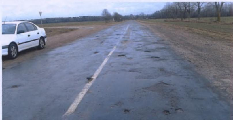
Рисунок 1 – Разрушение асфальтобетонного покрытия на повороте к сельхозугодьям
