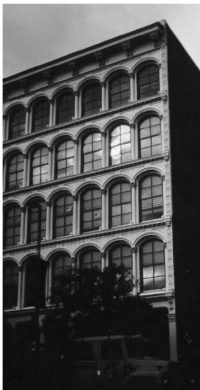
Рис. 3. Полнокаркасное промышленное здание в Филадельфии, США, XIX в.
