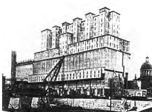
Рис. 6. Элеватор из монолитного железобетона, Канада, начало XX в.
