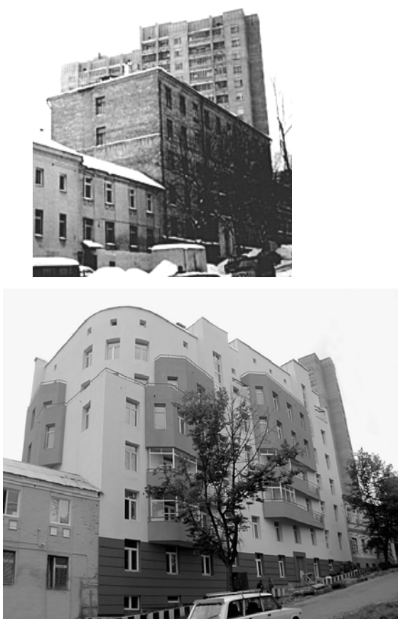
Рис. 4. Общий вид здания общежития в Самотечном переулке в г. Москва до и после перестройки
