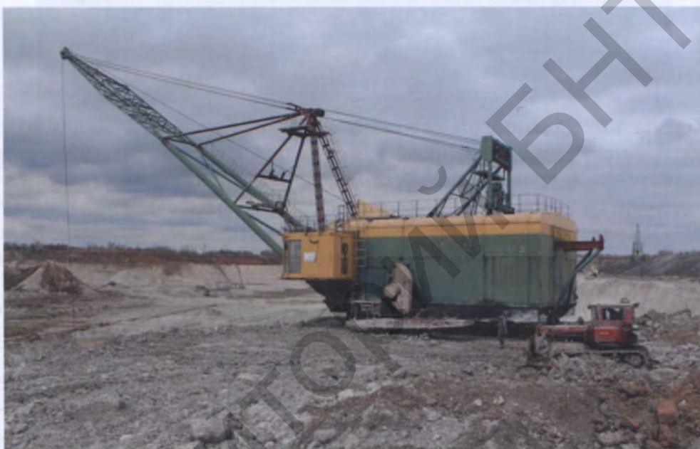
Рисунок 1 – Одноковшовый экскаватор на карьере по добыче мергеля (ОАО «Белорусский цементный завод, г. Костюковичи)
