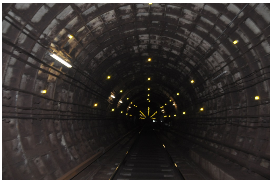
Рисунок 1 – Общий вид геодезических знаков, установленных на точки наблюдения за конструкциями перегонных тоннелей
