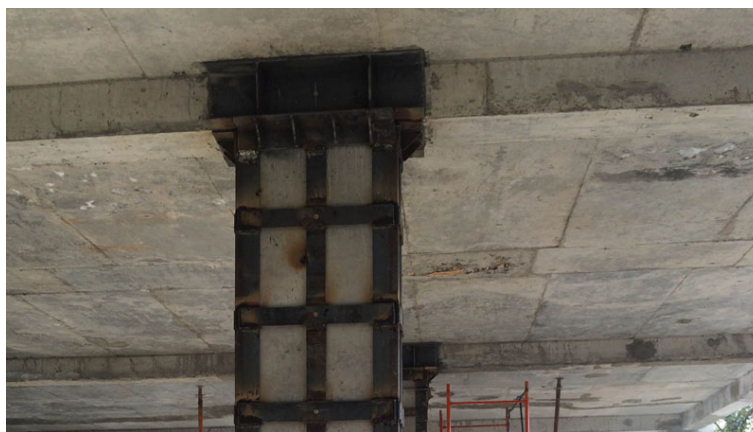
Рисунок 1 – Усиление традиционным методом
