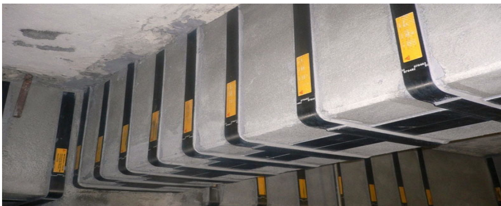
Рисунок 3 – Усиление железобетонной балки углеволоконным пластиком
