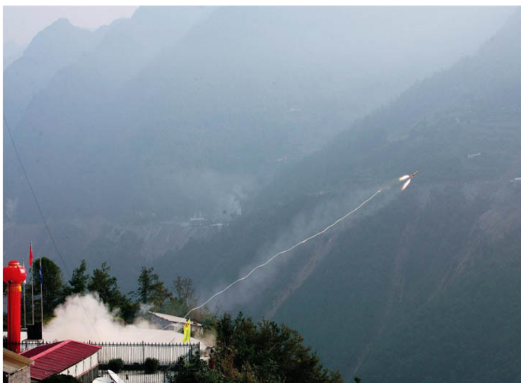
Рисунок 10 – Натягивание троса с помощью ракет
