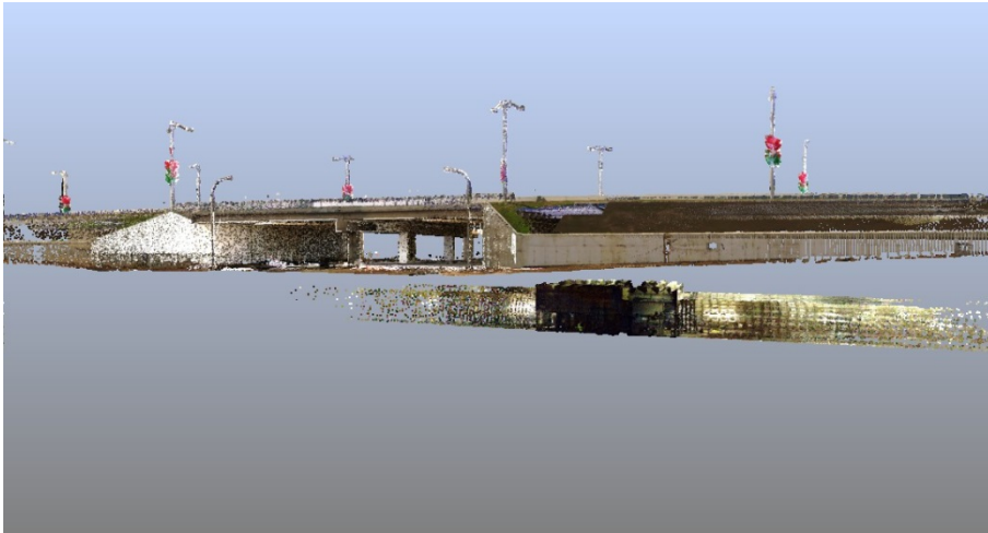
Рисунок 3 – Общий вид результата лазерного сканирования сооружений транспортной развязки
