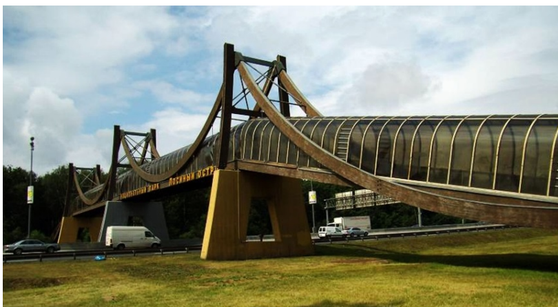
Рисунок 1 – Применение клееной древесины в мостостроении
