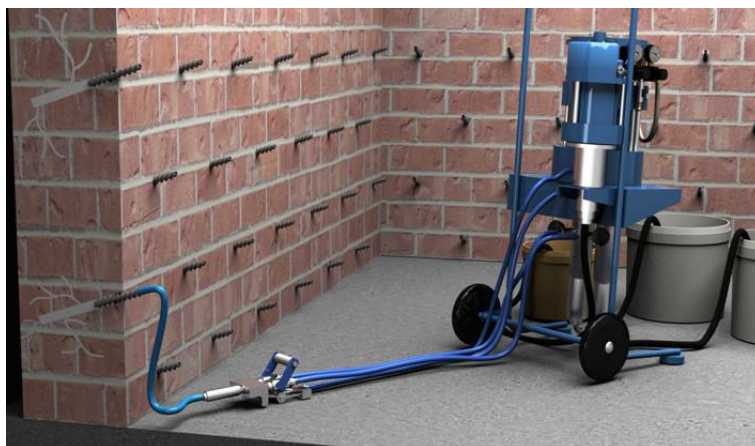
Рисунок 1- Наглядный пример инъекционной гидроизоляции кирпичной стены
