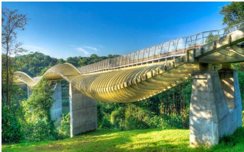
Рисунок 2 – Мост, выполненный из КДК
