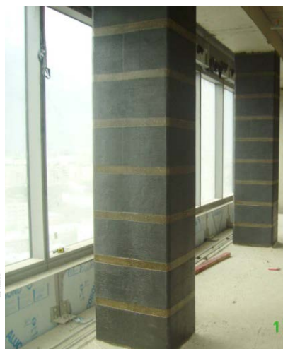
Рисунок 4 – Усиление колонны углеволоконными лентами
