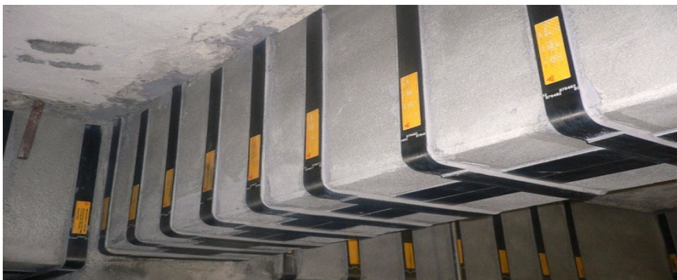
Рисунок 3 – Усиление железобетонной балки углеволоконным пластиком
