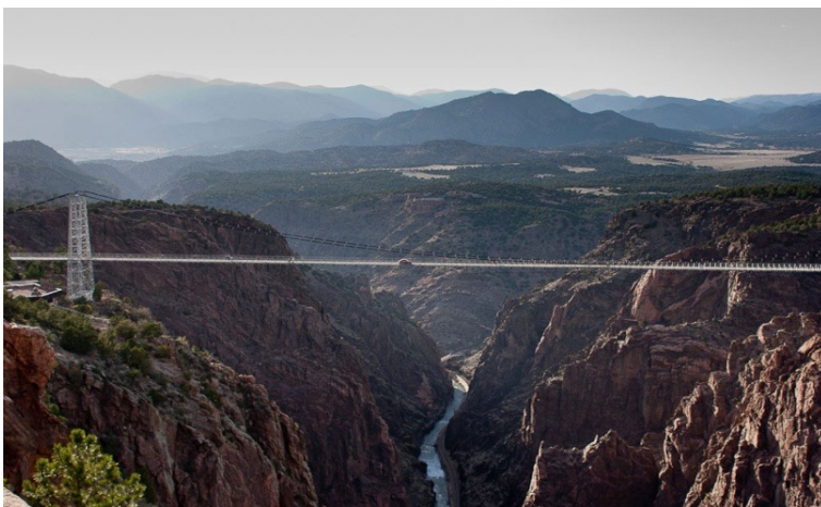
Рисунок 6 – Мост Ройал-Гордж. Вид сбоку
