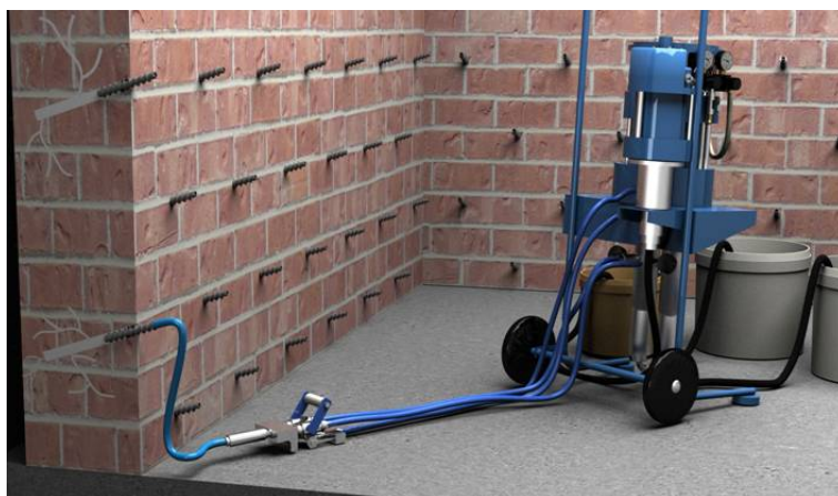
Рисунок 1- Наглядный пример инъекционной гидроизоляции кирпичной стены
