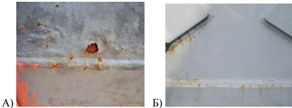
Рисунок 9А – Вспучивание и отшелушивание покрытия,
