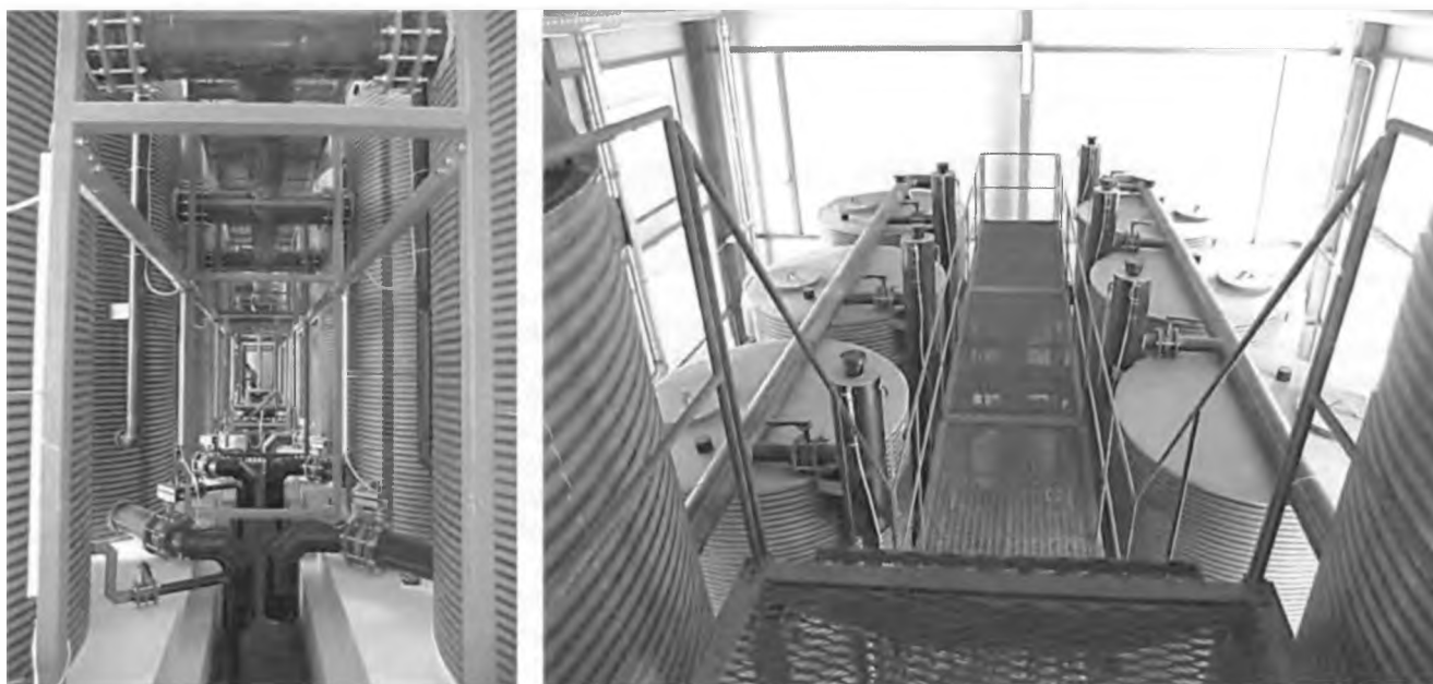
Рисунок 4. Общий вид станции биологического обезжелезивания и деманганации производительностью 6000 м 3 /сут в г. Краснодар.
