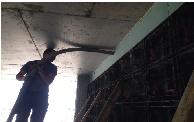
Рисунок 6 – Укладка полистиролфибропенобетонной смеси в конструкцию перегородки
