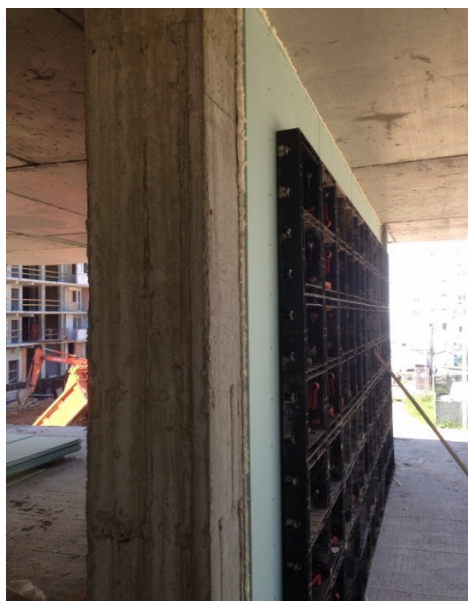
Рисунок 5 – Усиление конструкции перегородки легкой инвентарной опалубкой
