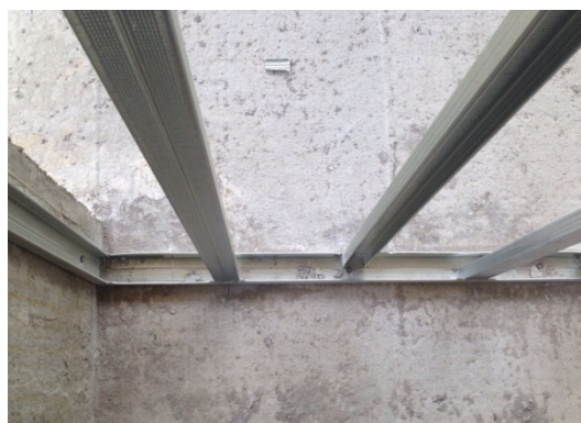
Рисунок 1 – Устройство каркаса перегородки
