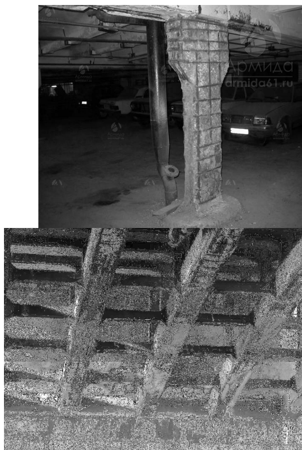
Рисунок 1 – Пример разрушение железобетонных конструкций
