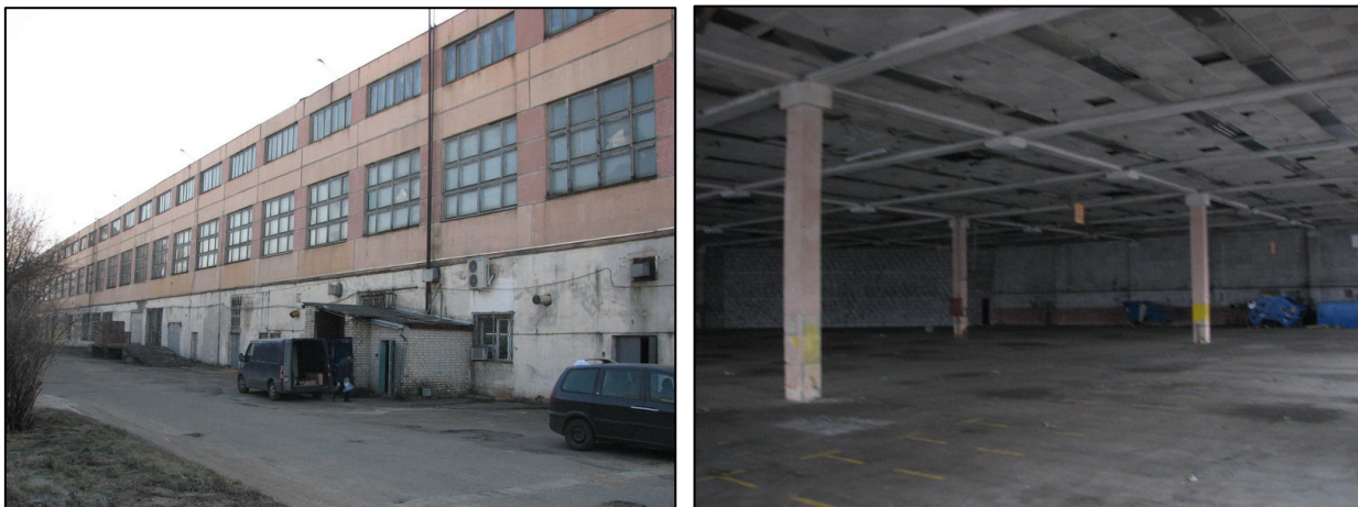
Рисунок 1 – Наружный и внутренний вид обследуемого здания
