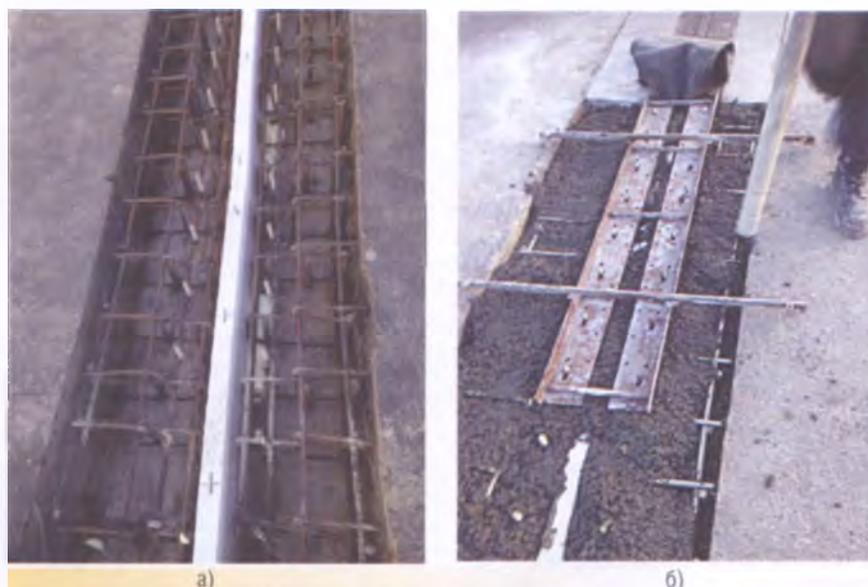
Рисунок 4. Конструкция ДШ с резинометаллическим компенсатором. Заполнение полостей ВБ.
