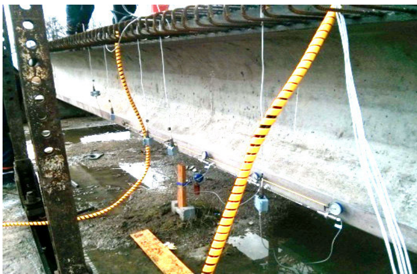
Рисунок 4 – Испытания железобетонной балки на строительном полигоне, г. Фаниполь
