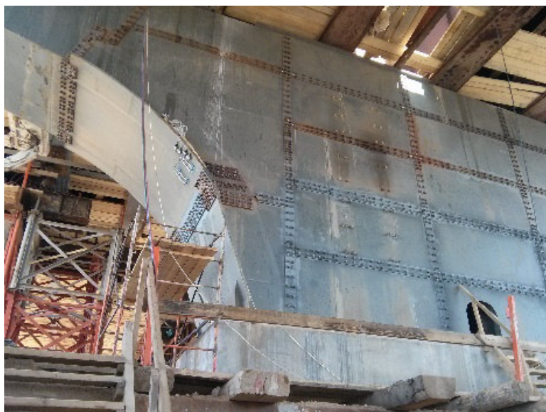
Рисунок 6 – Испытания опоры моста во время проведения ремонтных работ, г. Могилев.
