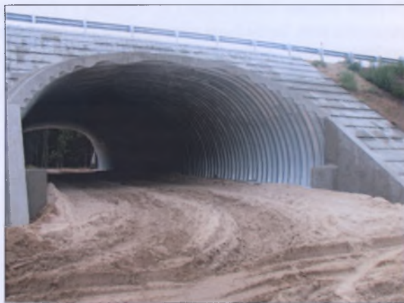
Рисунок 5 – Подземный переход для животных на автомобильной дороге М-5 Минск – Гомель, км 232,220
