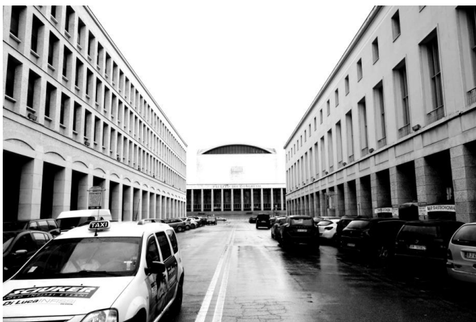
Рис. 2.25. Дисимметричная композиция застройки улицы, ведущей к Дворцу конгрессов в комплексе EUR в Риме
