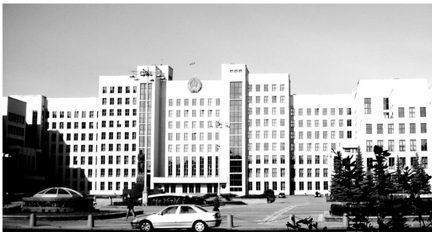
Рис. 2.24. Зеркальная симметрия, использованная для построения архитектурно-пространственной композиции Дома правительства (архит. И. Лангбард) в Минске
