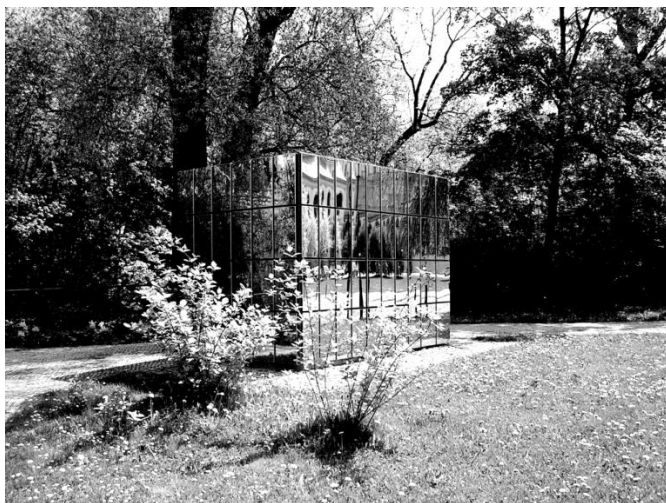
Рис. 5.14. Применение зеркальной облицовки поверхностей трансформаторной подстанции, Веймар, Германия
