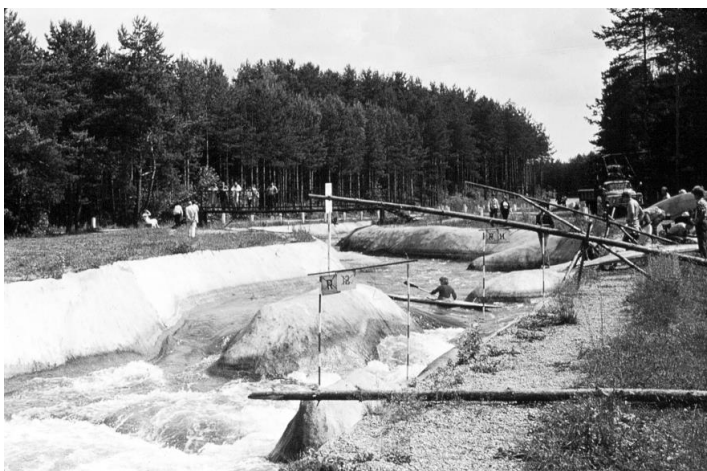
Рис. 4.16. Трасса водного слалома, которая одновременно обеспечивает необходимый водообмен в рекреационном водохранилище, зона отдыха Минское море
