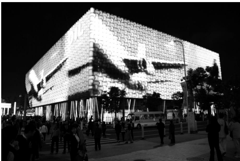
Рис. 5.20. Виртуальные декорации – фасады павильона «Нефть» на EXPO-2010 в Шанхае, на которые проецируются цветные движущиеся изображения
