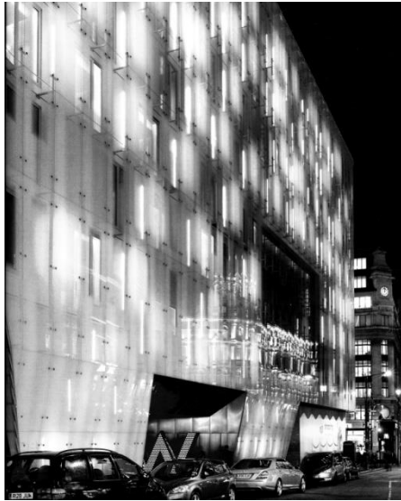
Рис. 5.8. На фасады отеля W London (архит. Дж. Вайлс и Д. Диллей) нанесен специальный отражающий слой, на который проецируются цветные изображения видов Лондона с 8 камер, установленных на крыше
