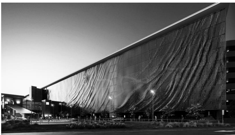
Рис. 5.19. Движущиеся декорации – фасад здания паркинга с подвешенными алюминиевыми пластинами, которые колышутся на ветру, аэропорт г. Брисбен, Австралия
