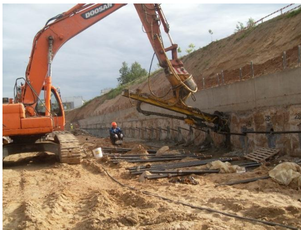
Рисунок 4. - Устройство анкеров
