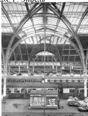
Рис. 136 Здание вокзала Пэддингтон. Лондон. 1854 г. Арх. И.К. Бранел и М.Д. Уайт (интерьер)
