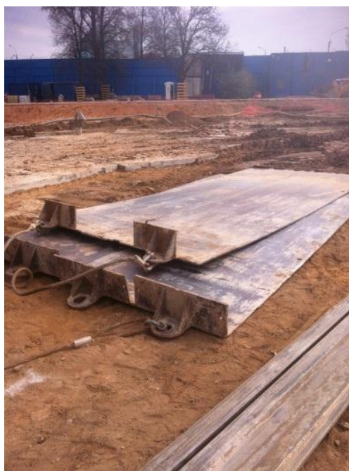
Рисунок 6. – Металлический лист для выравнивания лицевой поверхности стены в грунте
