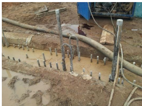
Рисунок 4. – Глинистый раствор между стенками форшахты
