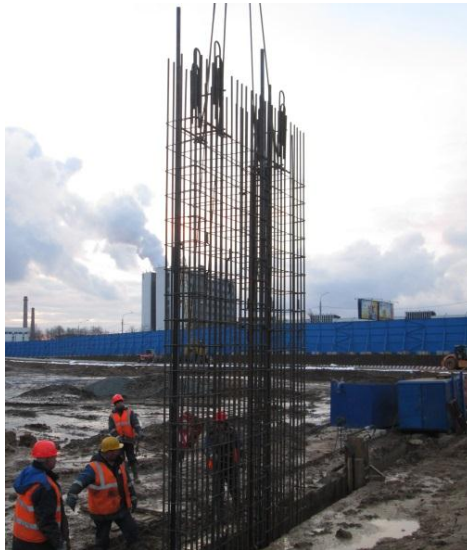
Рисунок 3. – Погружение армокаркаса в открытую секцию траншеи
