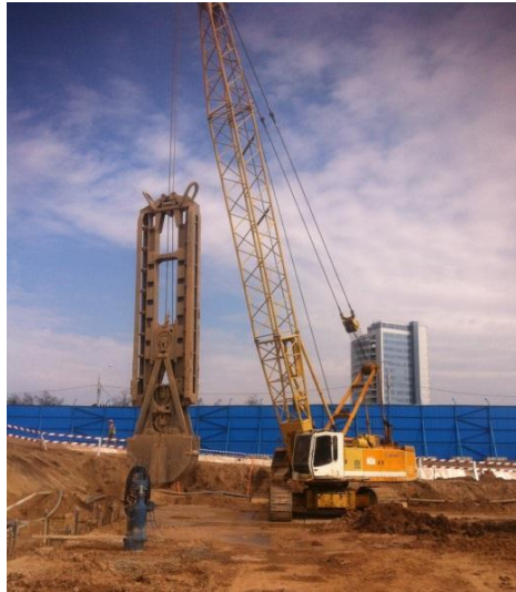
Рисунок 2. – Широкозахватный грейфер при отрывке траншеи для стены в грунте
