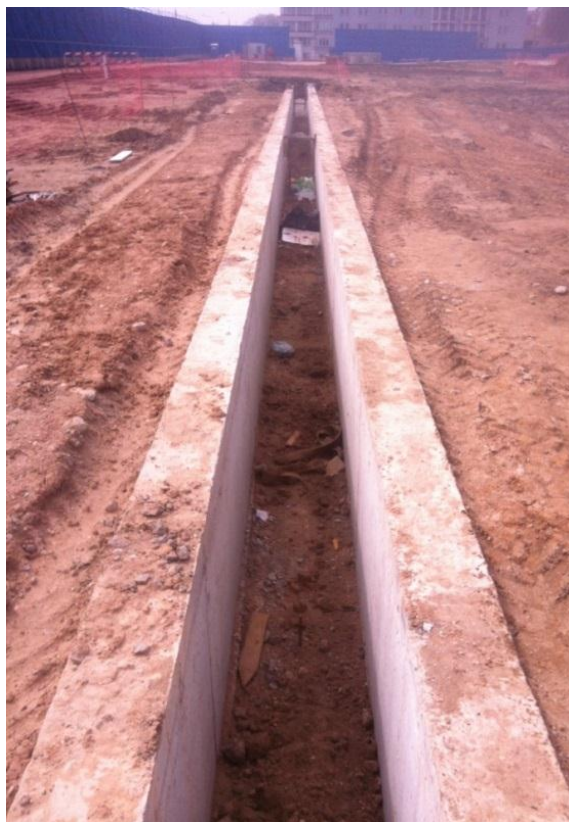
Рисунок 1. – Общий вид форшахты
