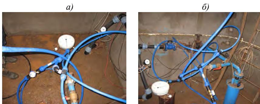
Рисунок 4.12 – Обвязка скважины при закачке воды в затрубную систему:
