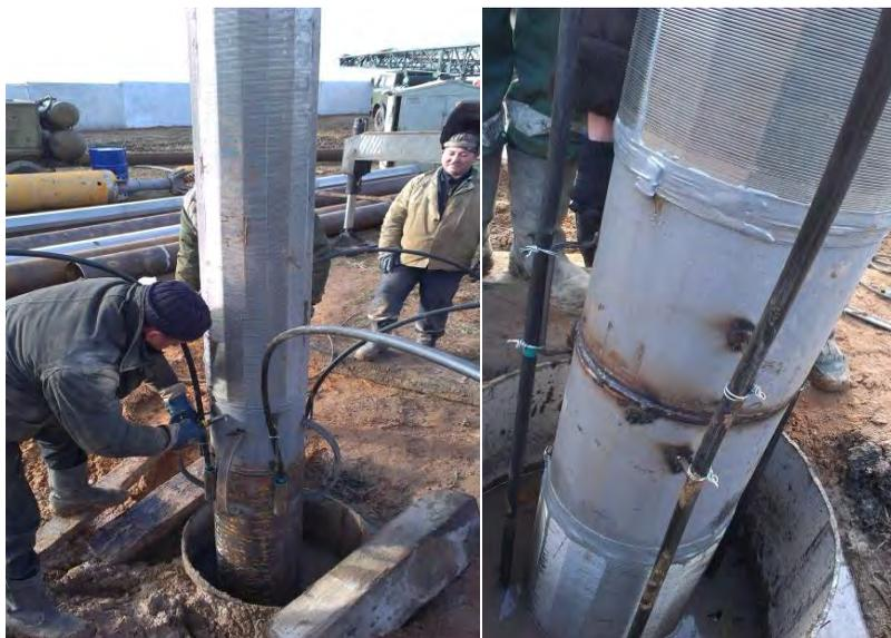
Рисунок 5.11 – Крепление трубок к фильтровой колонне
