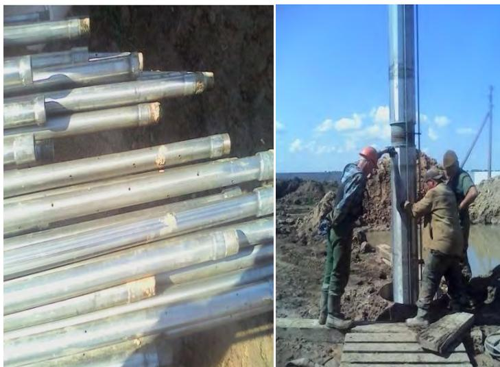
Рисунок 5.14 – Общий вид циркуляционных трубок из нержавеющей стали и спуск фильтровой колонны в ствол скважины
