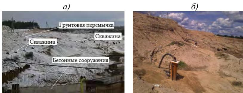
Рисунок 5.8 – Общий вид системы глубокого водопонижения Полоцкой ГЭС:
