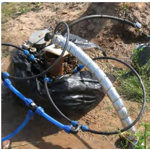
Рисунок 5.10 – Устье скважины №2.10 при гидродинамической промывке
