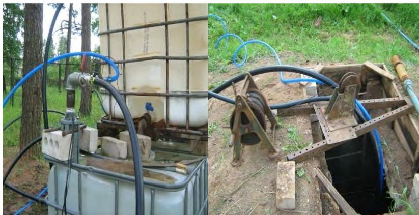
Рисунок 6.9 – Наземное оборудование гидроэлеваторной установки на скважине №2/2011 в д. Узла Мядельского района
