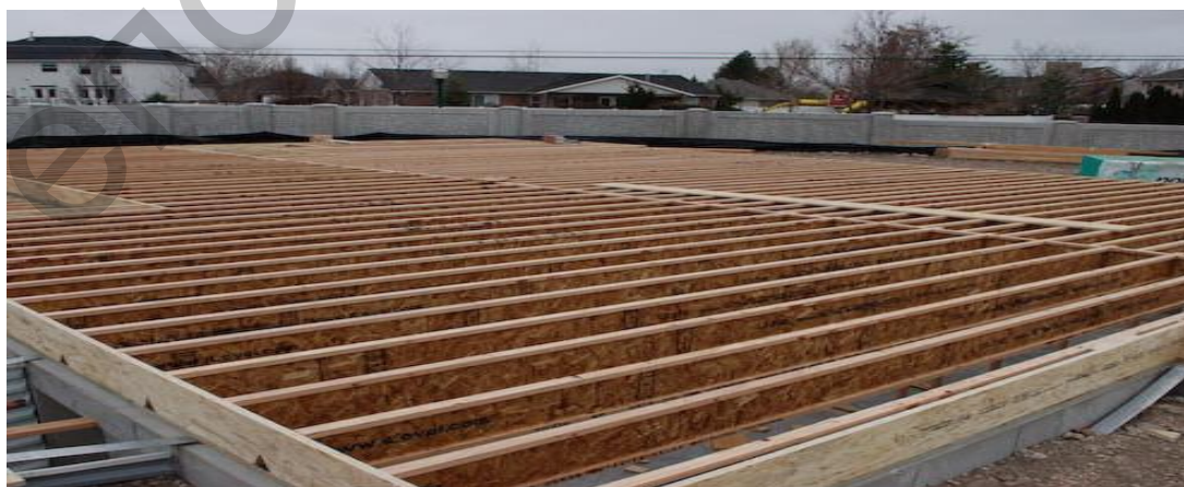
Рис. 1. Система перекрытий из деревянных двутавровых балок
