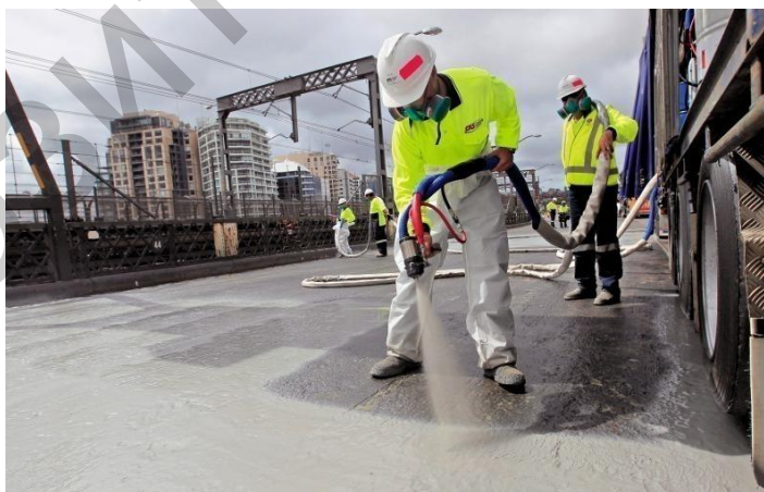
Рис. 1. Процесс нанесения двухкомпонентной напыляемой гидроизоляции
