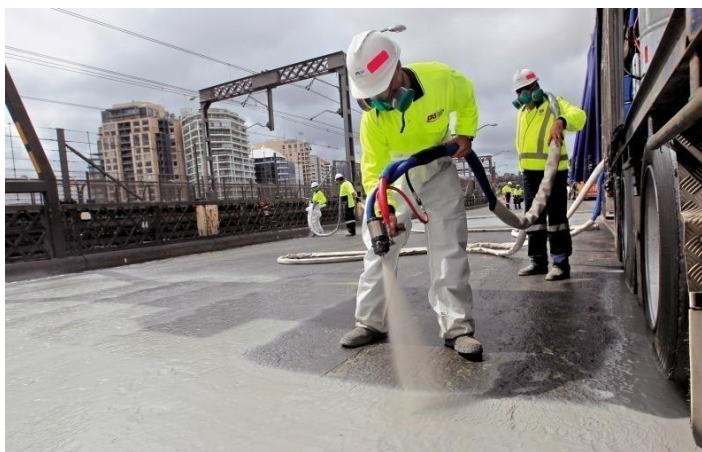
Рис. 1. Процесс нанесения двухкомпонентной напыляемой гидроизоляции
