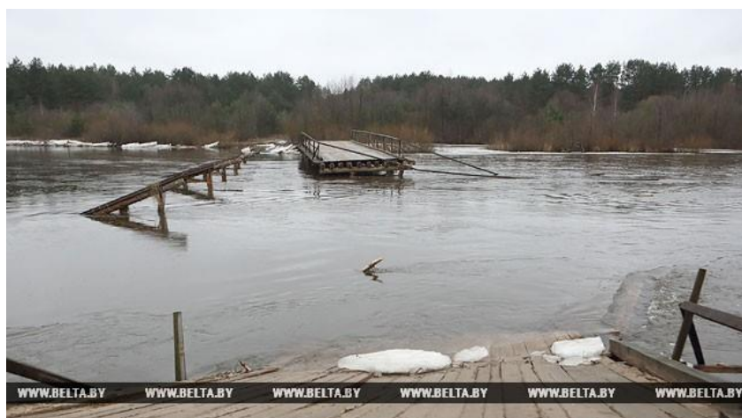
Рис. 3. Разрушенный деревянный мост на р. Неман
