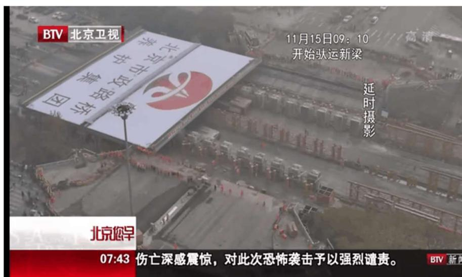
Рисунок 1 – Передвижение заранее смонтированного нового пролетного строения мост
