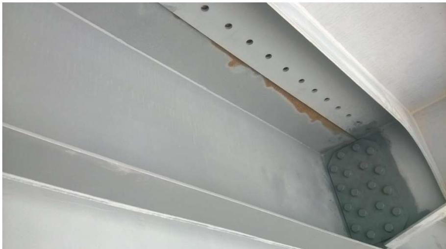
Рисунок 2 – Общий вид на металлические конструкции пролетного строения моста. Отсутствие защитного лакокрасочного покрытия, следовательно, развитие поверхностной коррозии элемента
