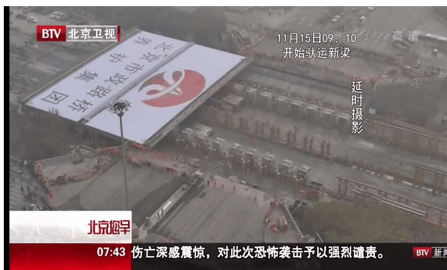
Рисунок 1 – Передвижение заранее смонтированного нового пролетного строения мост
