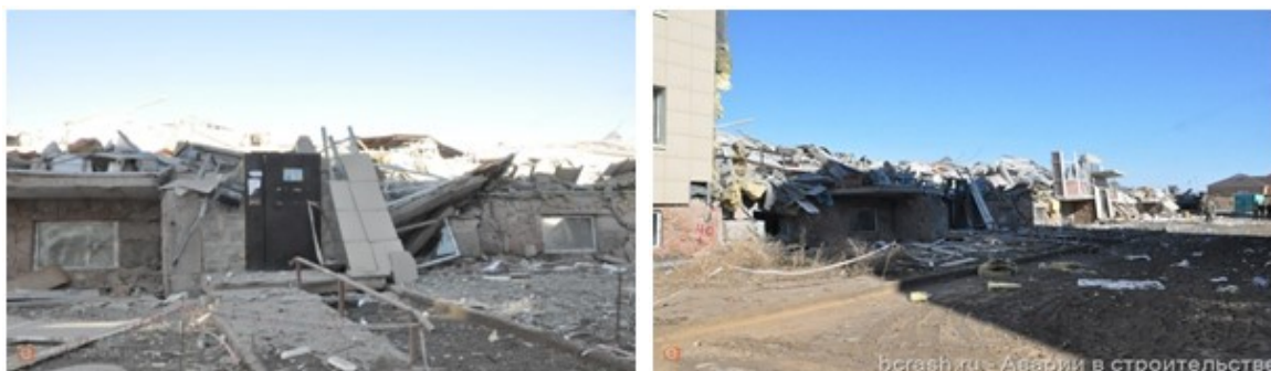
Рисунок 3 – Разрушенный дом в Караганде
