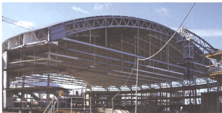
Рис. 1. Монтаж арок покрытия велотрека
